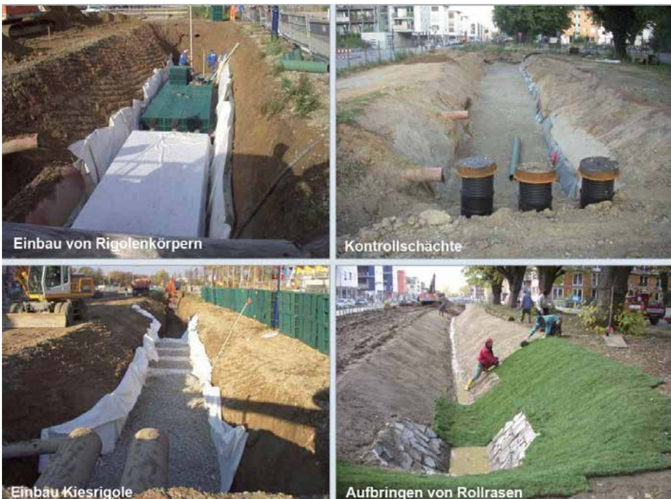
Abb.18 Bauliche Ausführung der Mulden-Rigolen (Fotos: E. Henkel).
