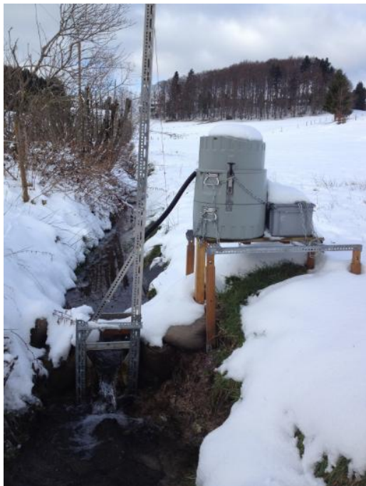
Abbildung 4: Abflussmessstation 1 mit Automatischem Probenehmer ( ISCO type: 6712 ) auf Podest und HT-Logger, oben an der Dexion-Konstruktion befestigt.
