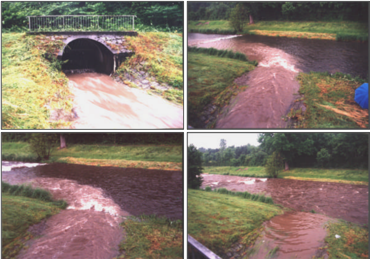
Abb. 4.21: Entlastungsereignis der Mischwasserkanalisation in die Dreisam am 06.06.02, aufgenommen im Zeitraum von 16 30 Uhr bis 17 30 Uhr am Entlastungsbauwerk MW-1.
