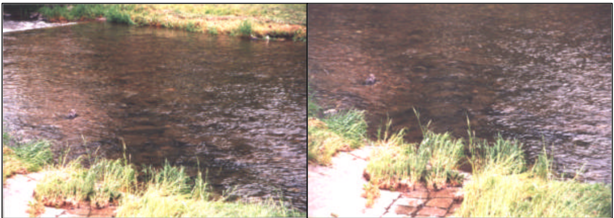
Abb. 4.19: Auskolkung der Gewässersohle im Auslauf der Mischwasserkanalisation am Entlastungsbauwerk MW-1 am 05.06.2002
