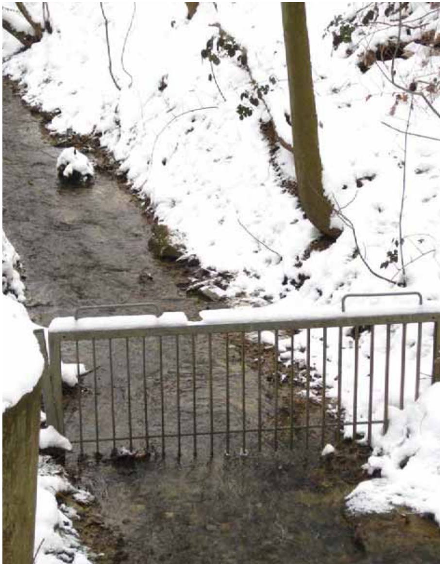
Abbildung 9.1: Beispiel einer Vorrichtung zum Rückhalt von Schwemmgut am Ehrenbächle.
