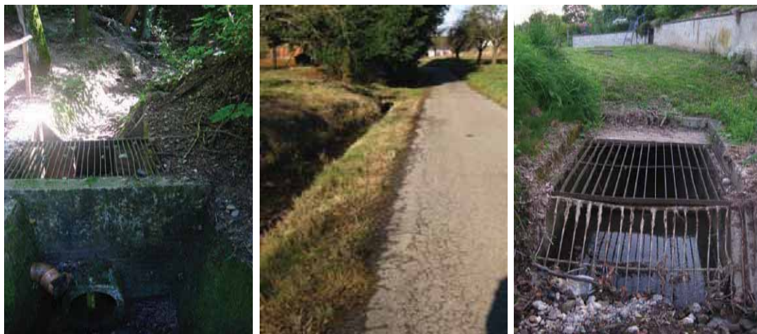
Abbildung D.8: Reduzierte Gewässerquerschnitte am Anderen Bach (links) und Einlauf des Dorfbaches in den verdolten Abschnitt (rechts). Beim Hochwasser vom 1. September 2008 stand das Wasser am Anderen Bach (mitte) etwa 20 cm über der Straße.
