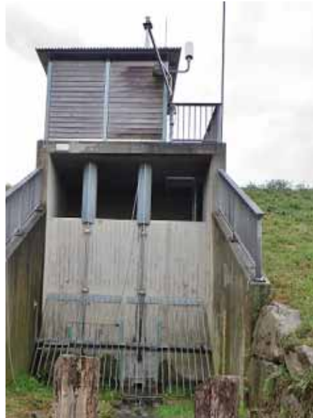
Abb. 9: Unteres Pegelhaus auf dem Staudamm mit Schiebern und Radarsonde
