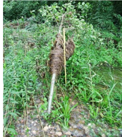
Abbildung A 27: verfangenes Geschwemmsel markiert an der nördlichen M1-Bresche die ehemalige Überflutungshöhe. Der als Maßstab dienende Zollstock ist ein Meter hoch (Aufnahme vom 02.07.2012).
