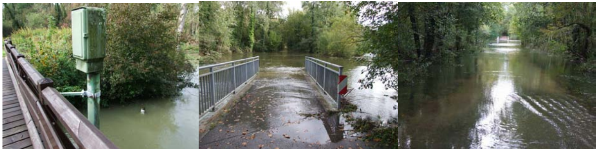
Abbildung 49: Grundwassermessstelle Nr. 22/067-5 als Teil des Grundwassermessnetzes des Regierungspräsidiums Freiburg. Der Lattenpegel im Hintergrund zeigt einen hohen Wasserstand an (links), Überflutete Furt der ehemaligen Rheinstraße an der Hausgrundkehle (Mitte). Rückwärtiger Blick auf vorige Brücke (rechts).
