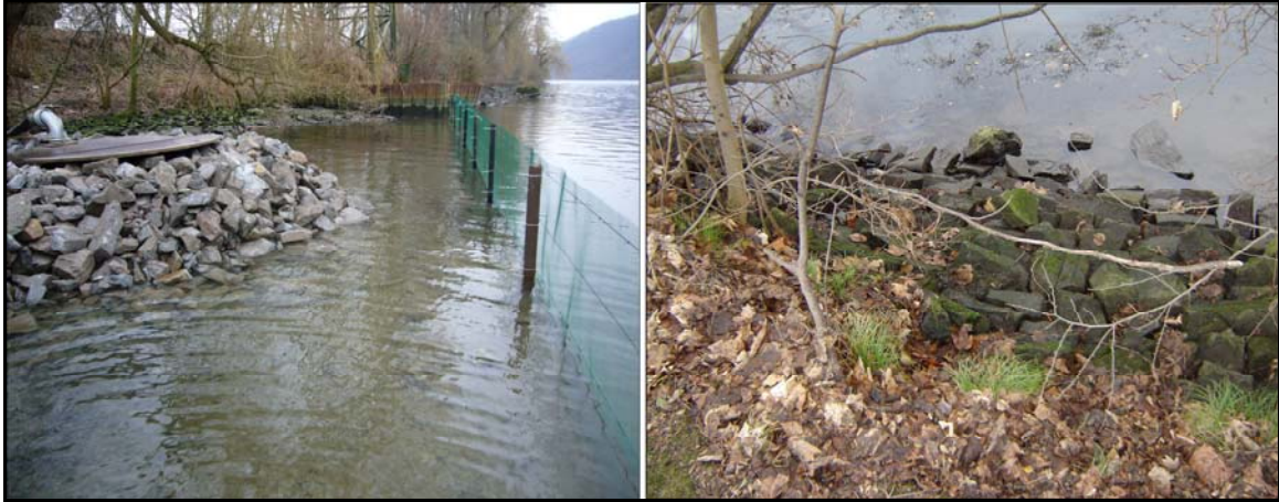
Abbildung A.1: Uferbefestigung des Südufers des Hengsteysees. Linke Seite: Uferstreifen mit Seepumpe in 2007 (STORA ENSO, 2009). Rechte Seite: Ufer im Dezember 2009, an ähnlicher Stelle wie Bild links.
