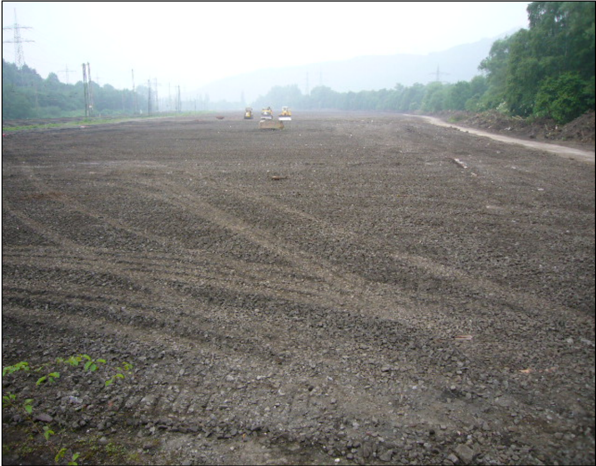
Abbildung A.3: Untersuchungsgelände zum Ende der Rodungs- und Vorbereitungsarbeiten. Im Vordergrund ist der wieder zutage tretende Schotter erkennbar (STORA ENSO, 2009).
