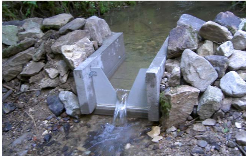
Abbildung 3-3: Abflussmessquerschnitt am Engebächle
