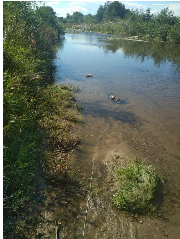
Abbildung A11: Zusätzliche Hochwassersicherung durch Stahlseil
