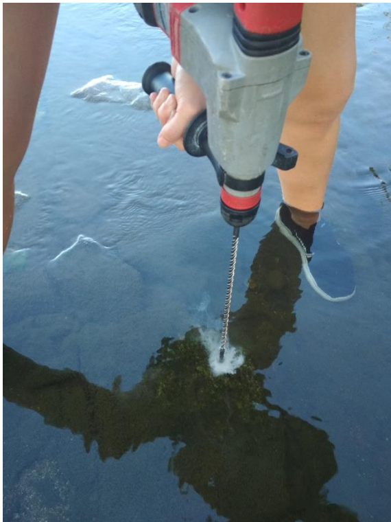
Abbildung A10: Lochbohrung vor Einschlagen des Spreizdübels
