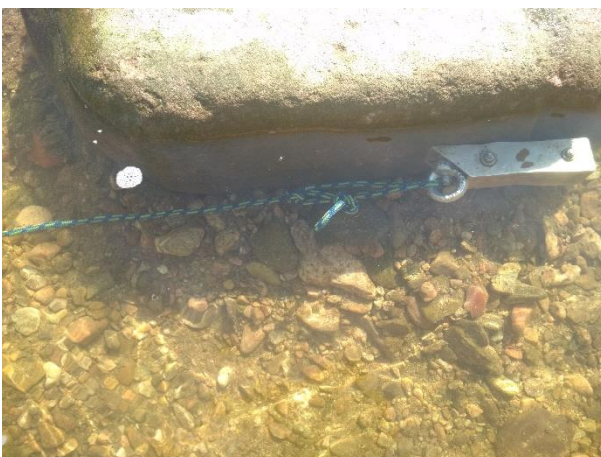
Abbildung A8: Hochwasserfester Hobo , zusätzlich mit einem Kletterseil gesichert
