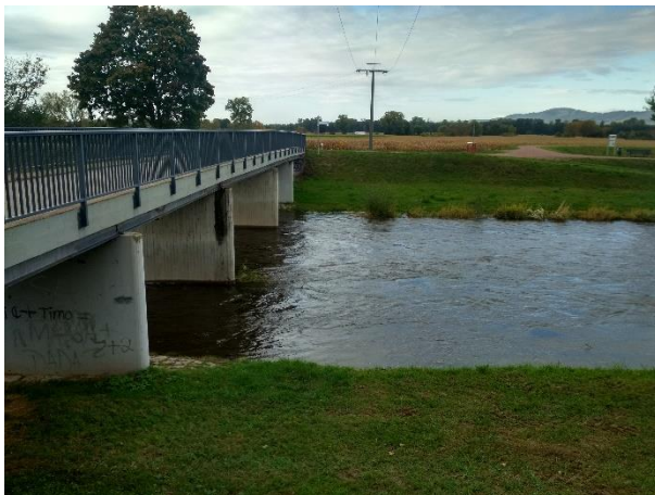
Abbildung A2: Standort MC, Messtelle Flussmitte unterhalb der Brücke
