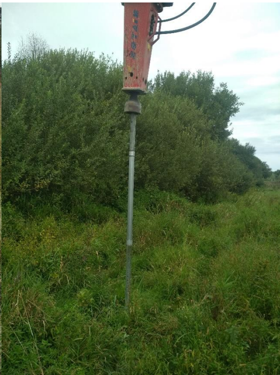
Abbildung A13: Einschlagen der Stahlrohre mittels Hydraulik Hammer
