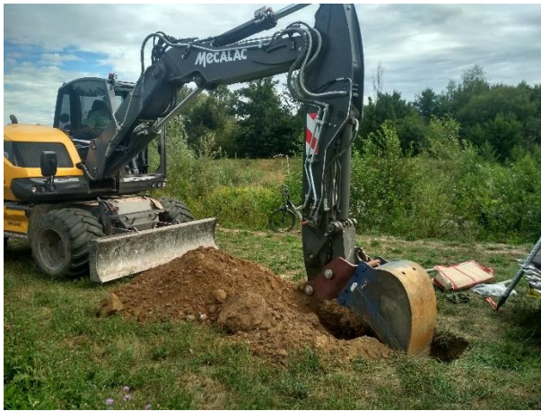
Abbildung A14: Aufbaggern der Messtelle GW1
