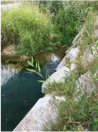
Abbildung A4: Zuflussstelle Z1 kurz vor der Schwelle
