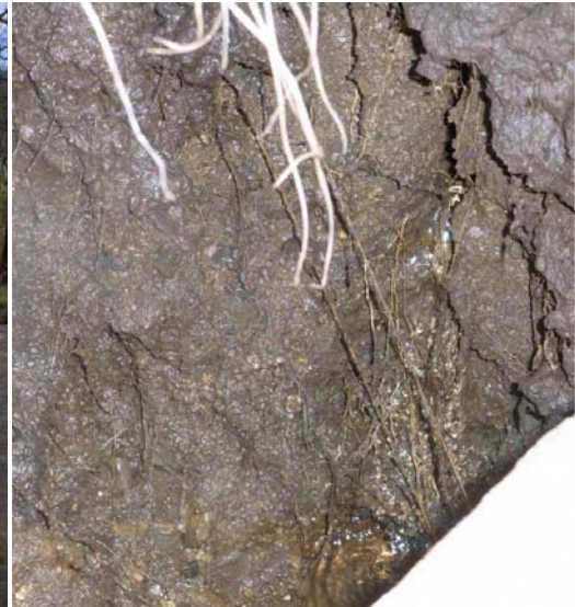
Abbildung 4.21: Aus einer Erdspalte, unter einem Stein, austretendes Hangwasser.
