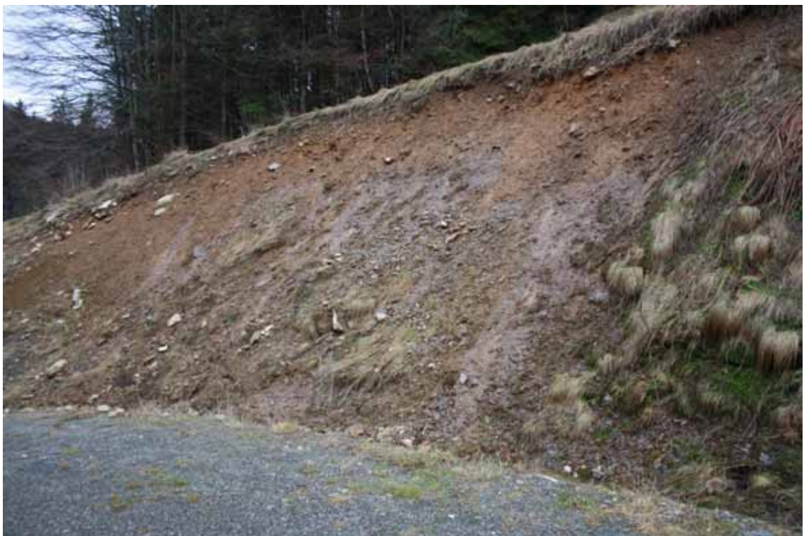
Abbildung A 4: Standort K3 (Bei genauer Betrachtung ist Makroporen- und Matrixfluss zu sehen).
